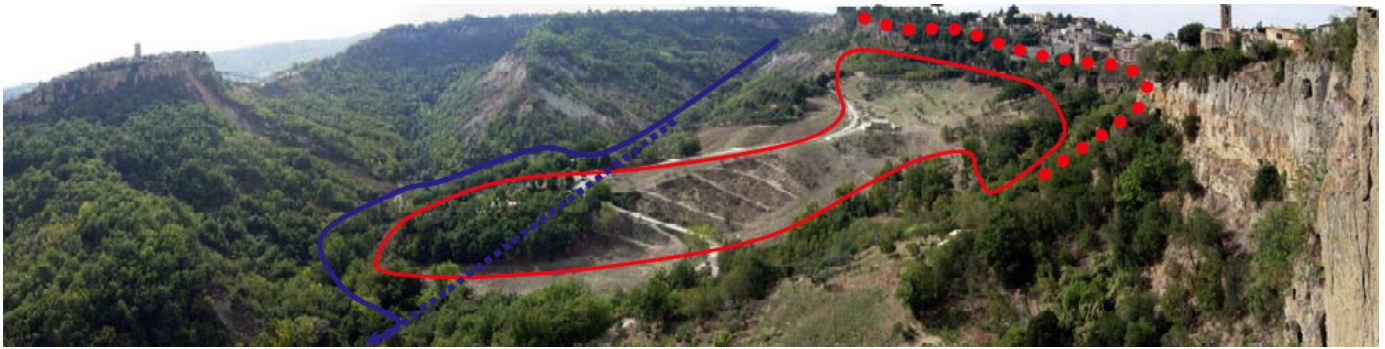
Figura 3. Area della frana del 1114 nel versante di Lubriano. Punti rossi: area di corona; linea rossa: corpo di frana; linea blu tratteggiata: corso originario del fosso di Lubriano; linea blu continua: attuale corso del Fosso di Lubriano.
