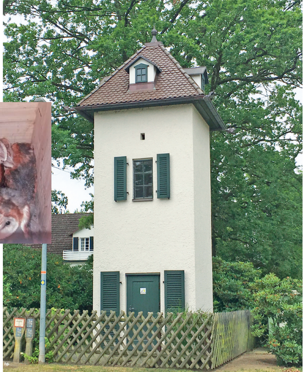
Vom Schandfleck zum Schmuckstück: Das ehemalige Trafo-Häuschen in Bockhorn erstrahlt seit einigen Jahren in neuem Glanz – und bietet nun einer Schleiereulenfamilie ein Zuhause. red (2)
