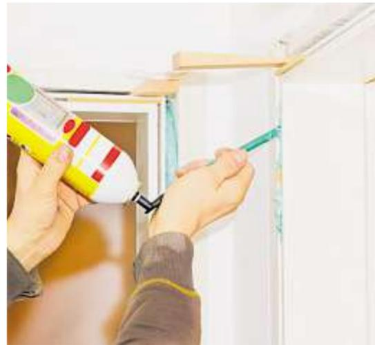
Punktuell soll der Hohlraum zur Wand mit speziellem Montagekleber gefüllt werden. Foto: Jürgen Flächle/stock.adobe.com
