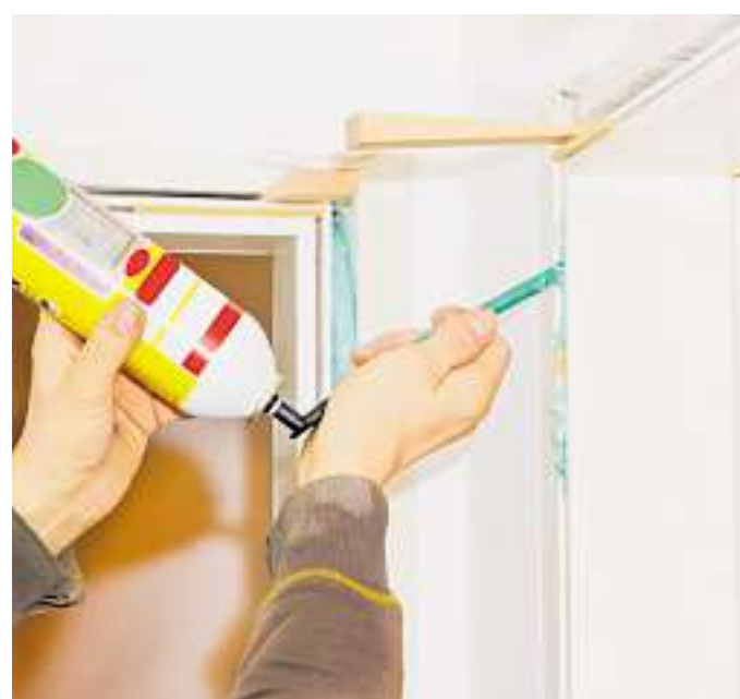
Punktuell soll der Hohlraum zur Wand mit speziellem Montagekleber gefüllt werden. Foto: Jürgen Flächle/stock.adobecom
