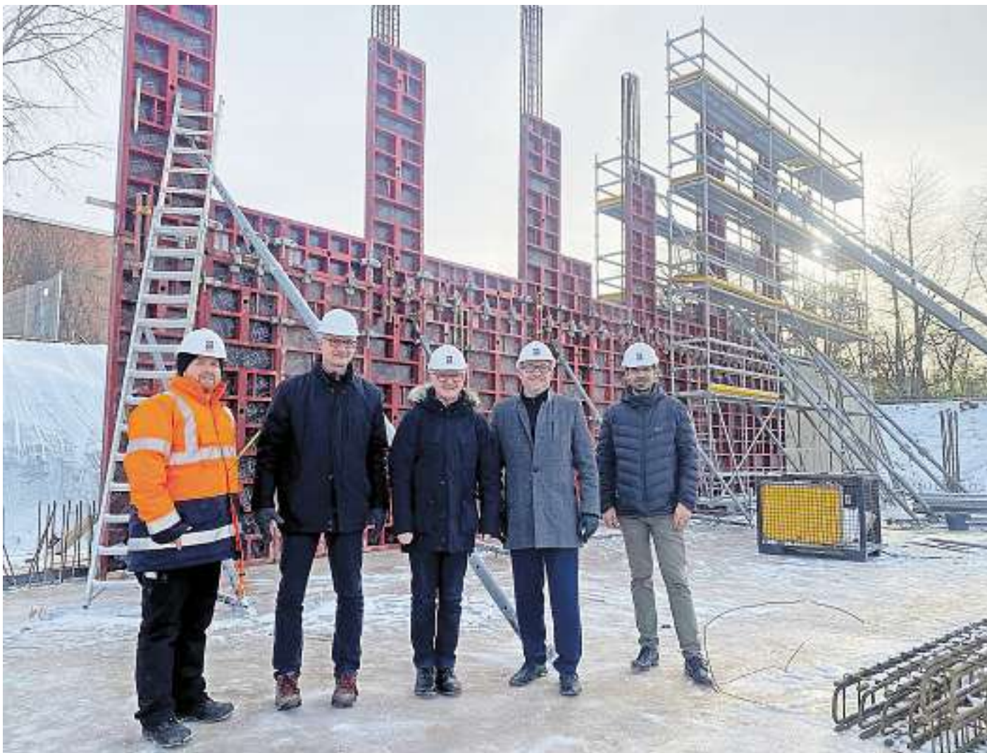
Kreisbaumeister Thorsten Mischo, Landrat Sören Meng mit Bürgermeister Dr. Armin König, Axel Schikorski von der Bautechnik-Abteilung des Landkreises und Polier Frank Wagner (von links) bei der Besichtigung der Baustelle der neuen Dreifeldhalle. Foto: Landkreis Neunkirchen/Carolin Stauner
