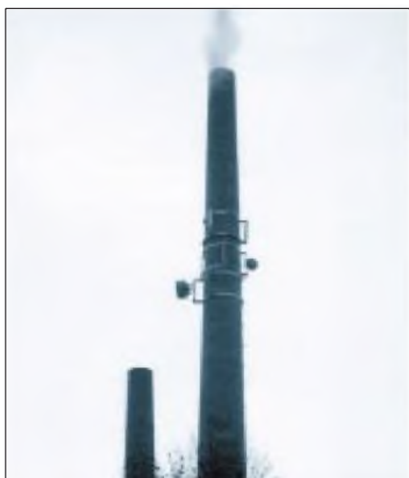
Anbau von Sektorantennen an einen Fabrik-schornstein
