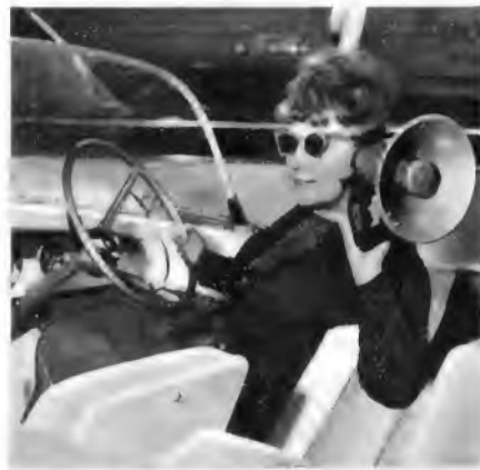
Aus England wird ein neuartiges transistorisiertes Megaphon importiert, das mit acht Mignonzellen, die im Handgriff untergebracht sind, betrieben wird. Es ist umschaltbar zum Sprechen, zum Hören der ankommenden verstärkten Schallwellen und zur Abgabe von Warntönen (Aufnahme: Schwahn)
