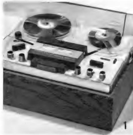
7. Bei der Aufnahme- und Wiedergabefunktion arbeitet das 22 HiFi-Special mit getrennten Tonköpfen und Verstärkern. Ein hoher Aufwand, der aber für jede Funktion ideale Bedingungen schafft, und darüberhinaus Mithören „hinter Band“ in Stereo – auch über eine angeschlossene Anlage – ermöglicht.
