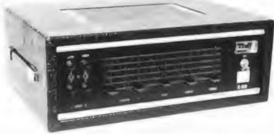
Durch seine große Betriebssicherheit, ausgewogene Klangregelung, enorme Sinusdauer- tonausgangsleistung von 190 W kann dieser Verstärker zur internationalen Spitzenklasse gezählt werden.
