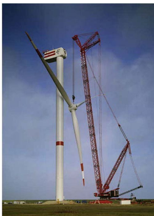
Kuva 3. Tuulivoimalan pystytys tela-alustaisella nosturilla (Liebherr).
