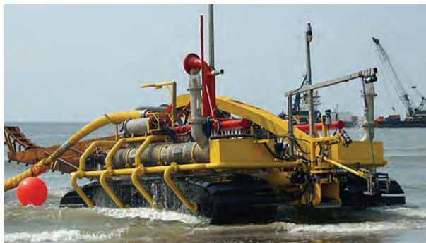
Figur 18 Utrustning för nedgrävning av kabeln (trencher) Källa Oceanteam
