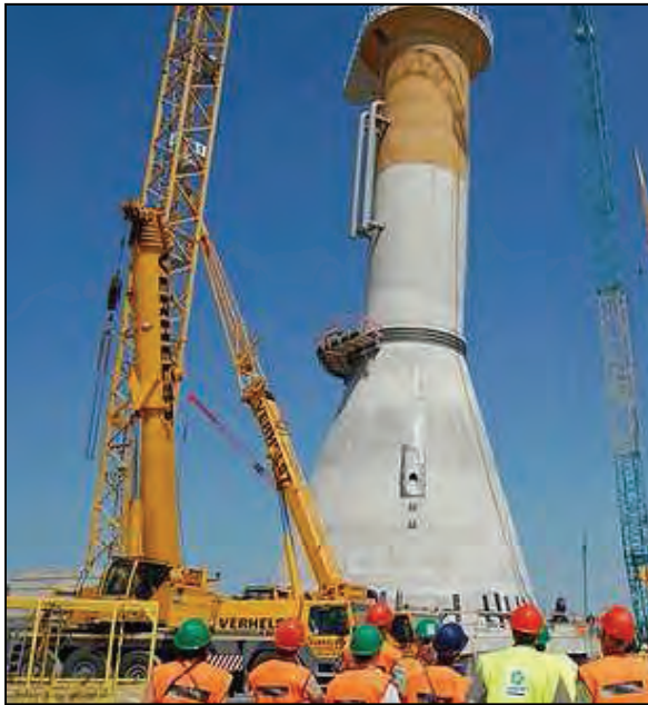
Figur 10 Bild från konstruktionsplatsen för fundament, projekt Thornton Källa: CarlBro
