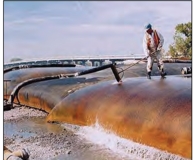
Figur 9 Exempel på "Geotube" Källa: Saipim s.a.
