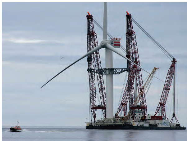
Figur 21 Montage av vindkraftverk sammansatt på land Källa STOAB
