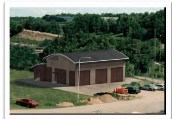
Figur 16 Exempel på inbyggd transformatorstation på land Källa: ABB
