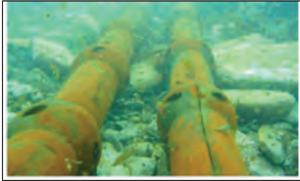
Figur 14 Exempel på erosionskydd för elkabel
