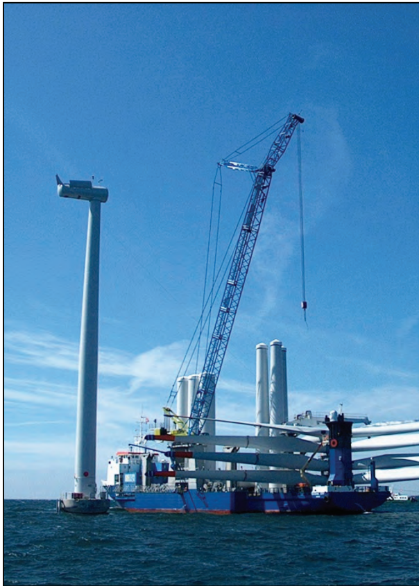
Figur 20 Montage av sammansatt rotor till havs Källa STOAB
