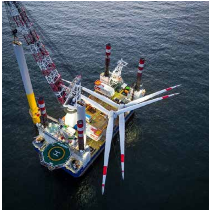
Figur 31. Installation av ett havsbaserat vindkraftverk. ©wpd
