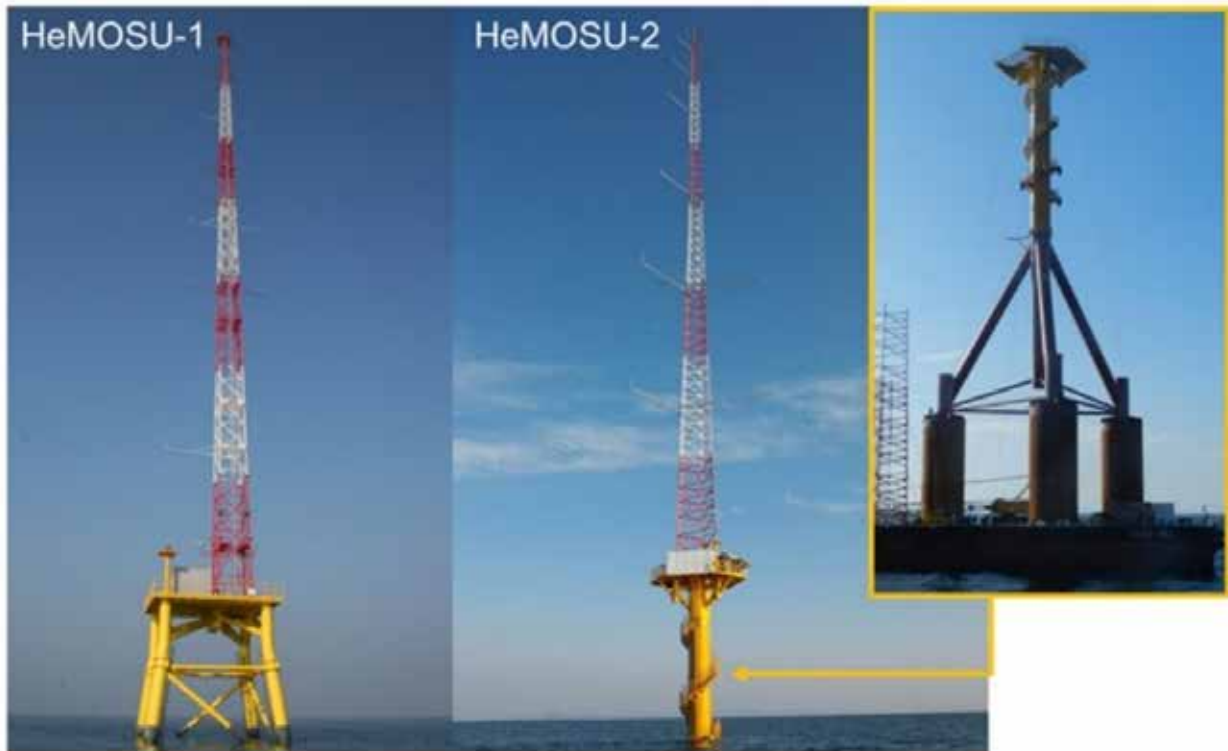
Figur 29. Alternativa fundamenttyper för mätmaster (Oh, Nam, Ryu, Kim, & Epureanu, 2018).
