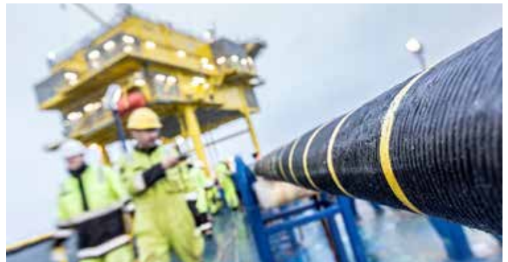
Figur 19. Bilden visar anläggning av elkabel i närheten av en transformatorstation ©wpd
