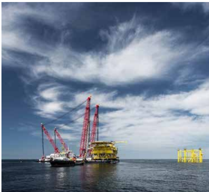
Figur 32. Installation av transformatorstation. ©wpd
