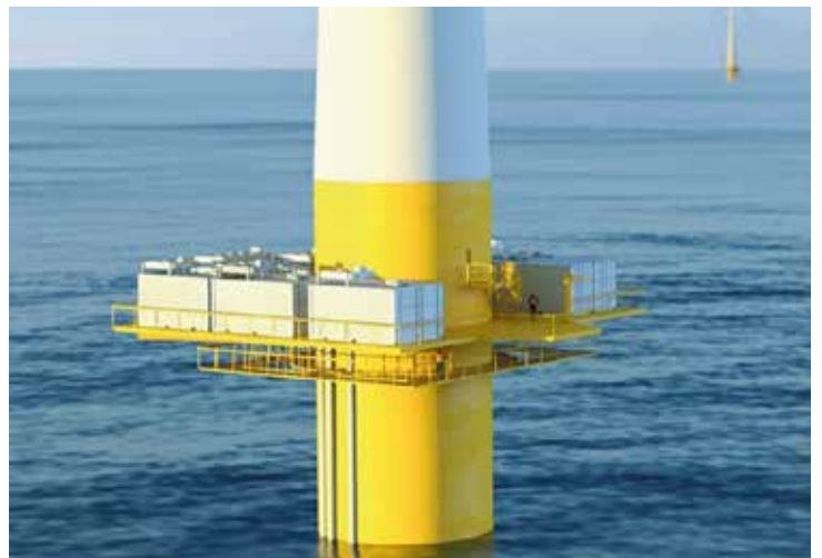
Figur 26. Exempelutformning av elektrolysanläggning vid vindturbin (AquaVentus, 2022).
