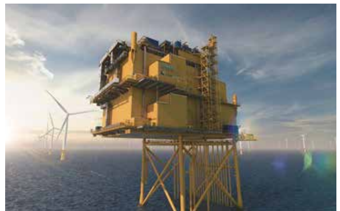
Figur 21. Exempel på omriktarstation (Siemens energy, 2021).
