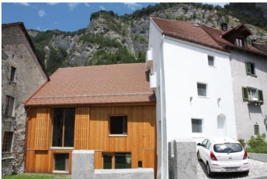
Altes und Neues respektvoll nebeneinander und erkennbar gestaltet
