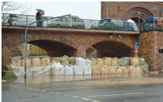
Erste Erfolge beim Hochwasser im Januar 2003: Einige Durchgänge mussten mit Big Bags oder Sandsäcken gesichert werden, aber die Altstadt blieb trocken.
