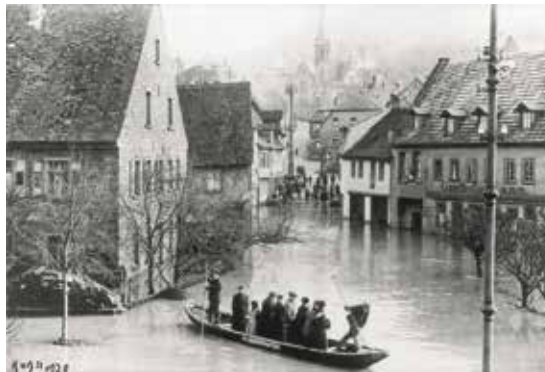
Aufnahme vom Hochwasser 1920 (etwa 30-jährliches Hochwasserereignis)
