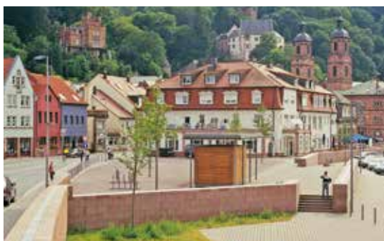
Der Bereich der östlichen Brückenrampe während der Bauarbeiten
