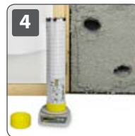
4 Dichteproofung am befüllten Prüfelement mit Dichteproofset NW100
