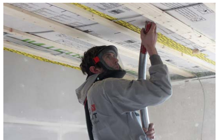
Einblasnadel mit speziell geformter, farblich markierter Rohrspitze als Einstechhilfe
