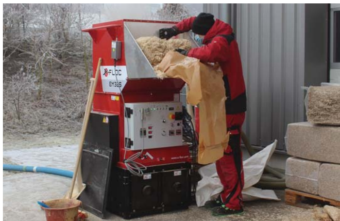
Befüllung der Maschine mit dem Naturdämmstoff
