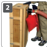
2 Verdichtetes Einblasen mit entlüfteter Drehdüse
