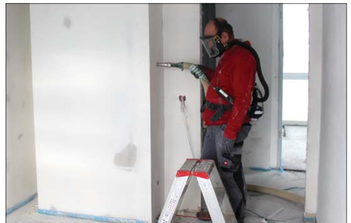
Schachtverfüllung
