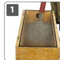
1 Offenes Aufblasen mit Schlauch
