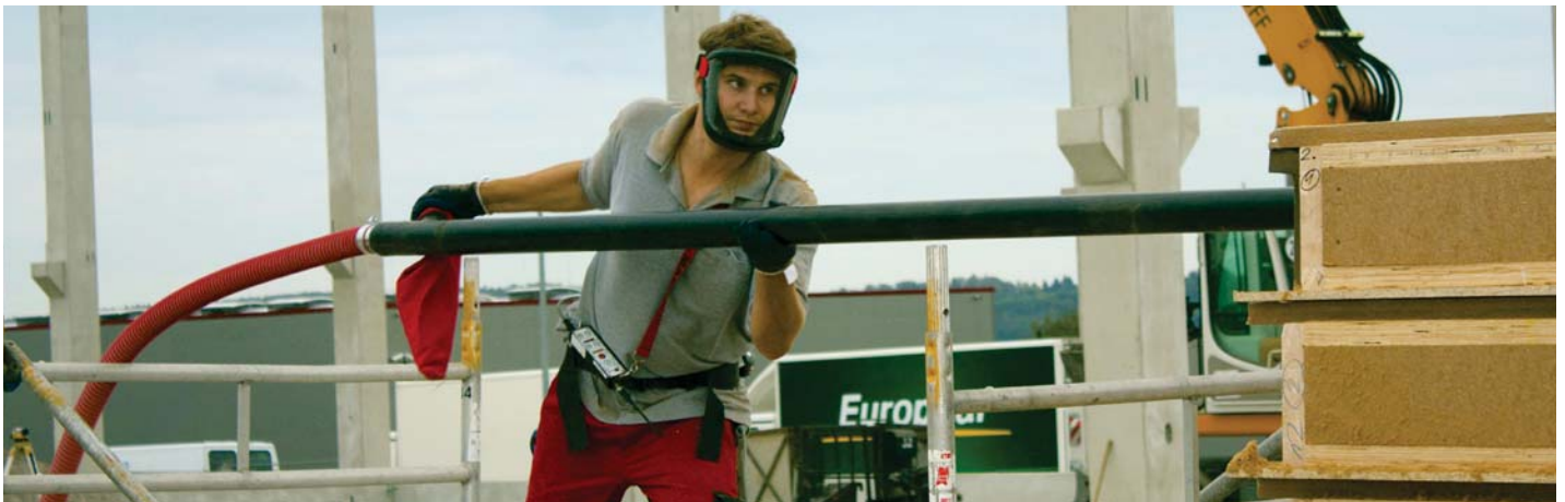
Elementbefüllung auf Industrieniveau mithilfe entlüfteter Einblaslanzen
