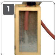
1 Verdichtetes Einblasen mit Schlauch
