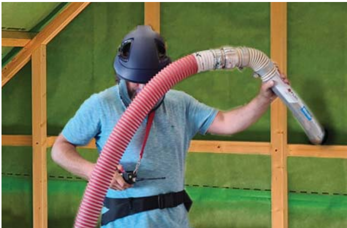
Schlauchdrehverbinder (SDV) erleichtern das Arbeiten mit der Einblasnadel
