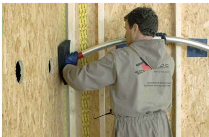
Einblasnadeln sind auch zum Befüllen hart beplankter Gefache bestens geeignet
