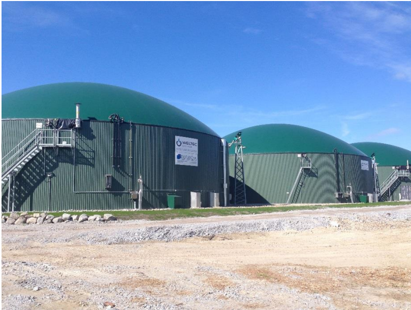
Kuva 8. Mädätysreaktorit
