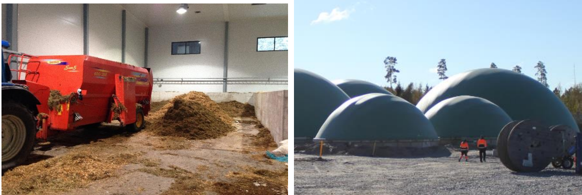
Kuva 22. Vasemmassa kuvassa vastaanottosiilo sisätiloissa ja oikealla etualalla vastaanottosäiliöt
