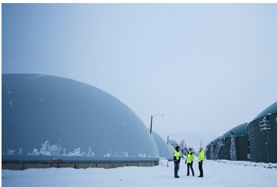
Kuva 21. Varastosäiliöitä kuvan vasemmassa reunassa
