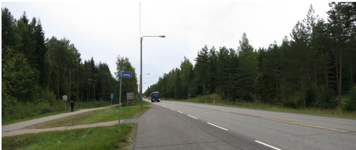
Kuva 30. Maijanaron yhdystien liittymäkohta valtatiellä 6
