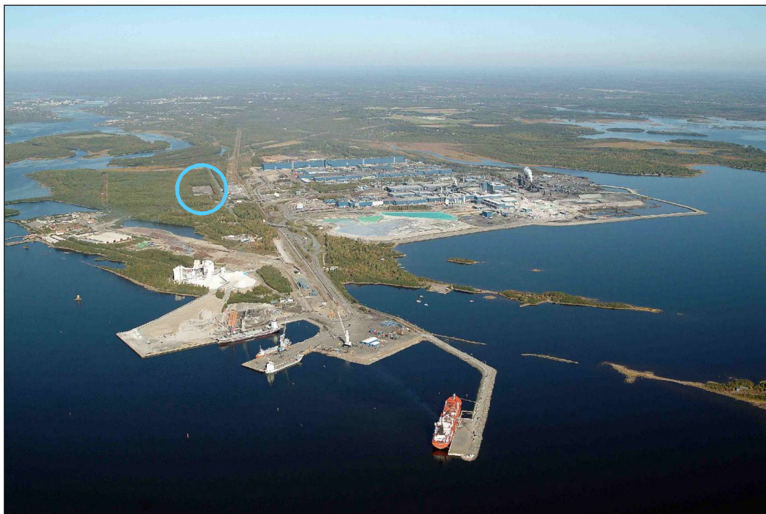
Kuva 7-10. Röttän alue ilmasta kuvattuna (Maa ja Vesi Oy 2005). Kuvan etualalla on satama ja taakse levittäytyy muu tehdasalue. Hankealue on ympäröity kuvaan sinisellä.
