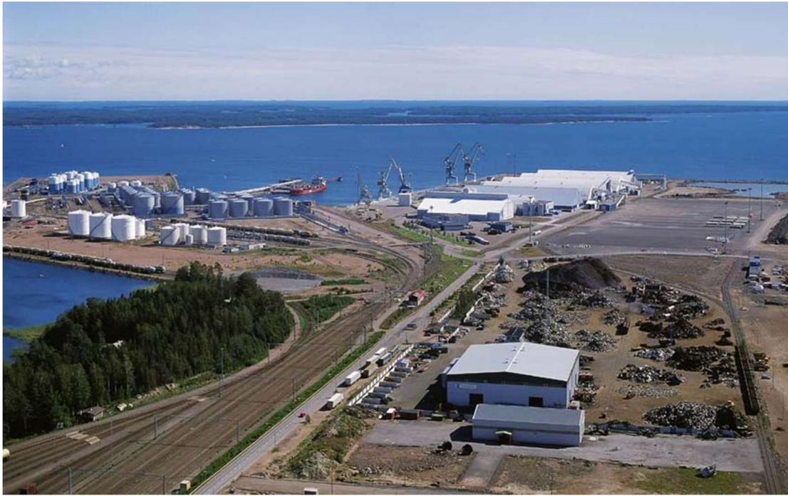
Kuva 2-4. Ilmakuva Kuusakoski Oy:n Kotkan Mussalon satamassa sijaitsevalta palvelupisteeltä (Kuusakoski Oy 2015).
