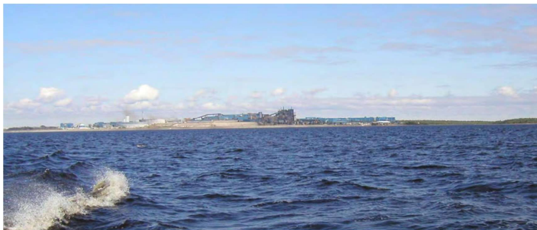
Kuva 7-9. Näkymä mereltä Röttän satamaan ja Outokummun tehdasalueelle (Tornion kaupunki 2005).
