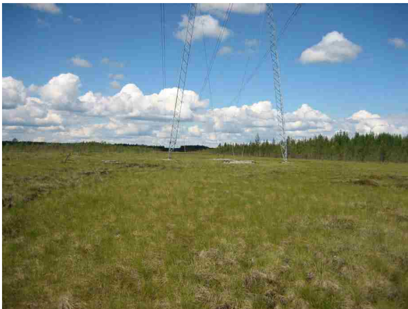
Kuva 12. Olemassa olevan voimalinjan pohjoisemmän ylityskohdan kohdalla on lyhytkorsinevaa. Kuvattu kaakosta luoteeseen (Kuva: Heikki Holmén).
