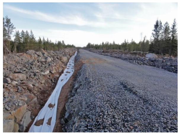
Kuva 17. Maakaapelit upotetaan huoltoteiden yhteyteen (kuvat: Ville Suorsa/FCG).
