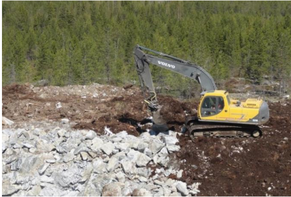
Kuva 16. Tuulivoimahankkeen rakentaminen alkaa huoltoteiden ja pystytysalueiden rakentamisella (kuvat: Ville Suorsa, FCG).
