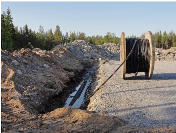
Kuva 17. Maakaapelit upotetaan huoltoteiden yhteyteen (kuvat: Ville Suorsa/FCG).
