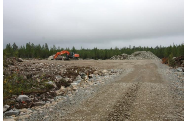
Kuva 16. Tuulivoimahankkeen rakentaminen alkaa huoltoteiden ja pystytysalueiden rakentamisella (kuvat: Ville Suorsa, FCG).
