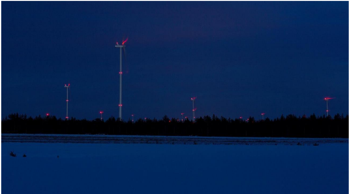
Kuva 12. Kiinteät punaiset lentoestevalot. (Kuva: Ville Suorsa, FCG)
