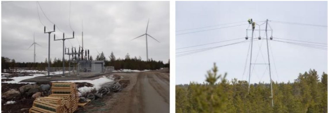
Kuva 21. Sähköaseman ja voimajohdon rakentamista (kuvat: Ville Suorsa/FCG)
