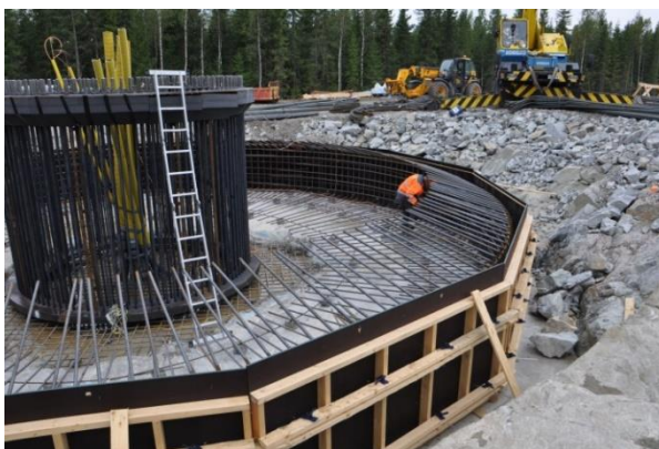
Kuva 18. Tuulivoimalan perustusten rakentamista. (Kuvat: Leila Väyrynen, FCG)
