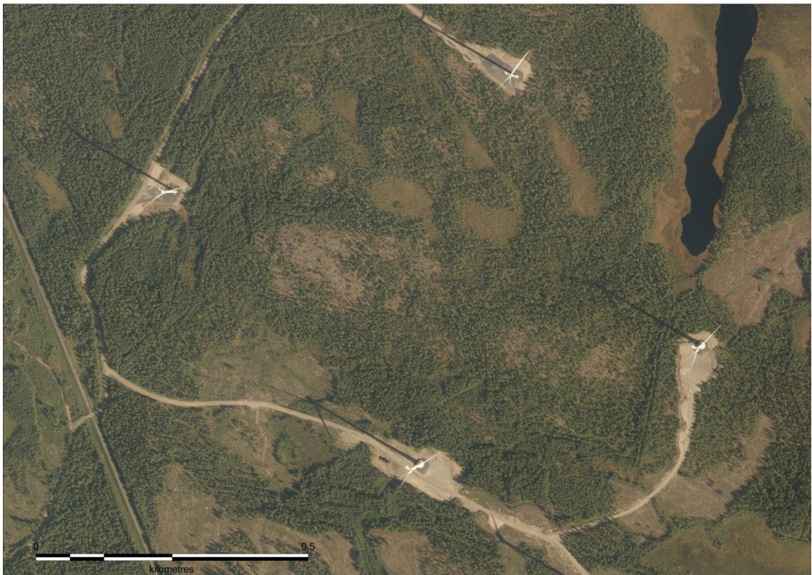
Kuva 10. Ilmakuvasa näkyy toiminnassa olevia tuulivoimaloita. Tuulivoimaloita varten on rakennettu huoltotiet ja nostokentät. Tuulivoimaloiden ympäristössä ja välialueilla aikaisempi maankäyttö on säilynyt ennallaan.
