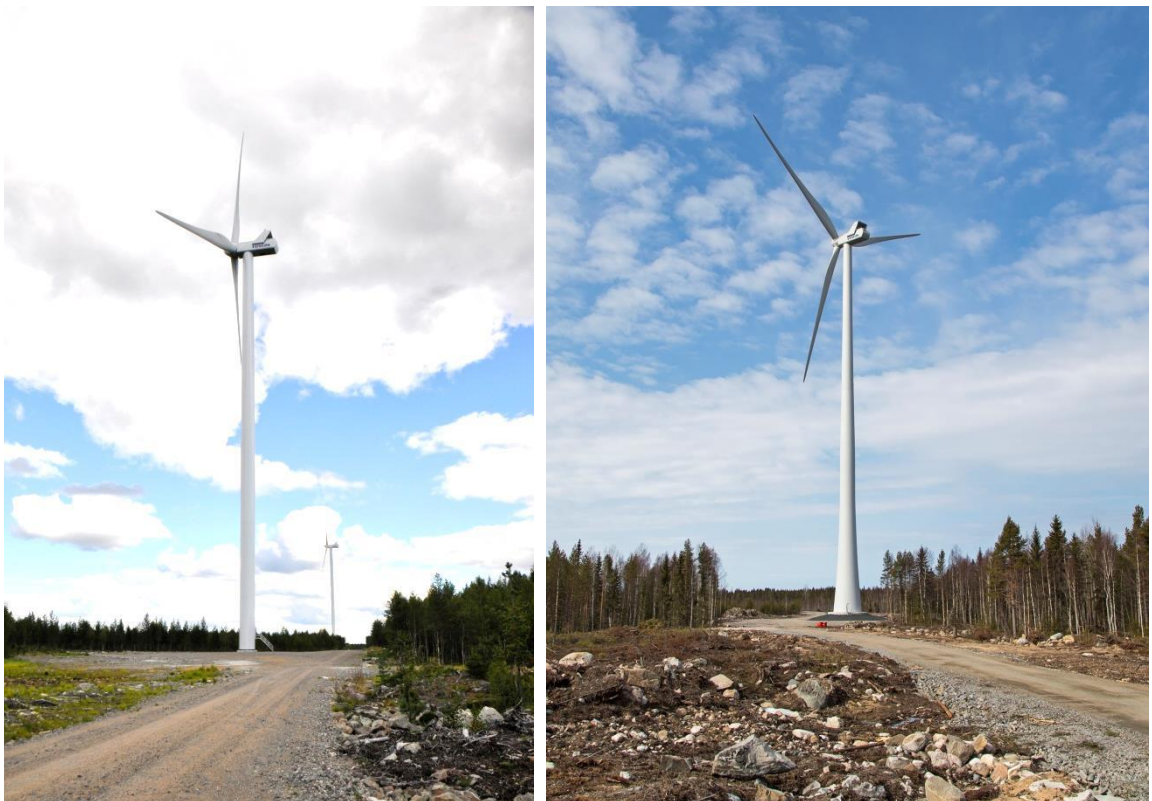
Kuva 11. Vasemmalla on esimerkki teräslieriötornista ja oikealla hybriditornista. (Kuvat: Leila Väyrynen ja Ville Suorsa, FCG)
