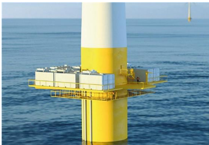
Kuva 4-4. Havainnekuva merituulivoimalan yhteyteen rakennetusta elektrolyysilaitoksesta (AquaVentus 2022).
