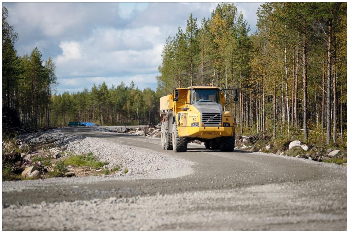
Kuva 6-6. Esimerkkikuva tuulivoimalan rakenteilla olevasta huoltotiestä (Kuva: OX2).
