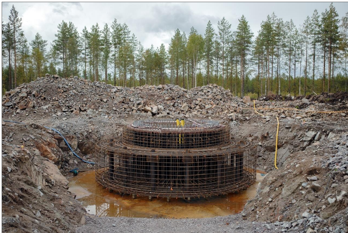
Kuva 6-4. Esimerkkikuva kallioankkuriperustuksesta (Kuva: OX2).
