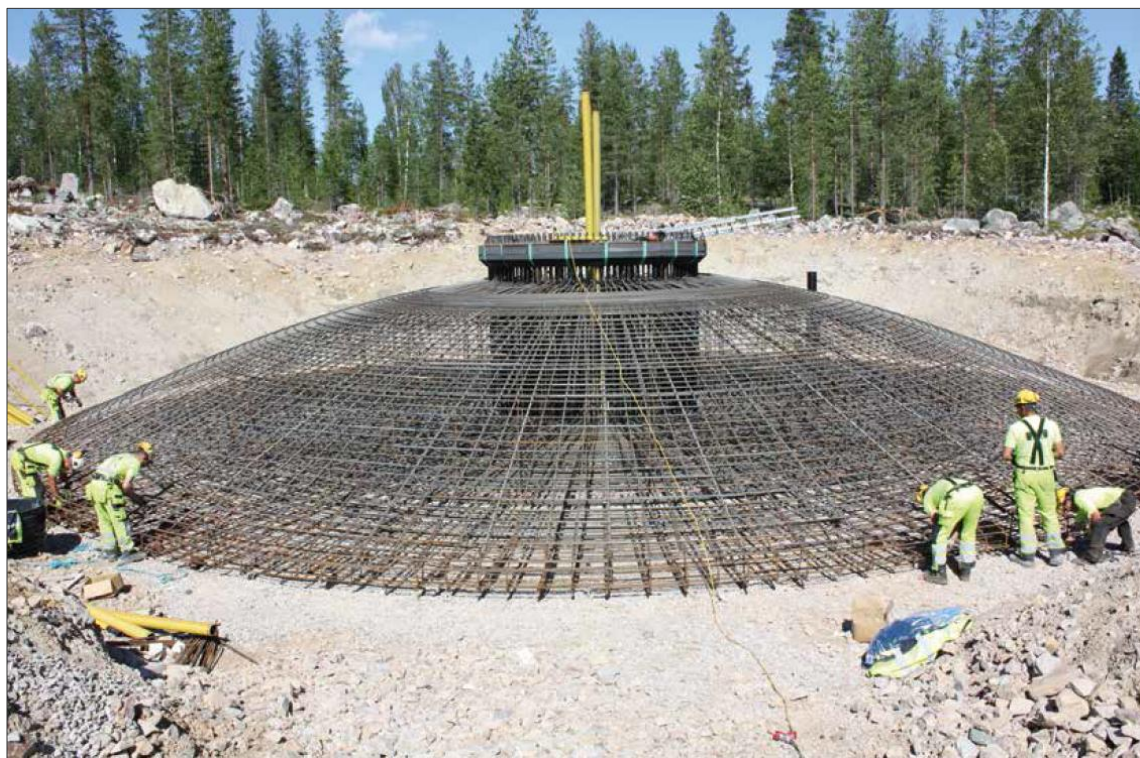
Kuva 6-3. Maanvarainen teräsbetoniperustus raudoitettuna ennen betonivalua.
