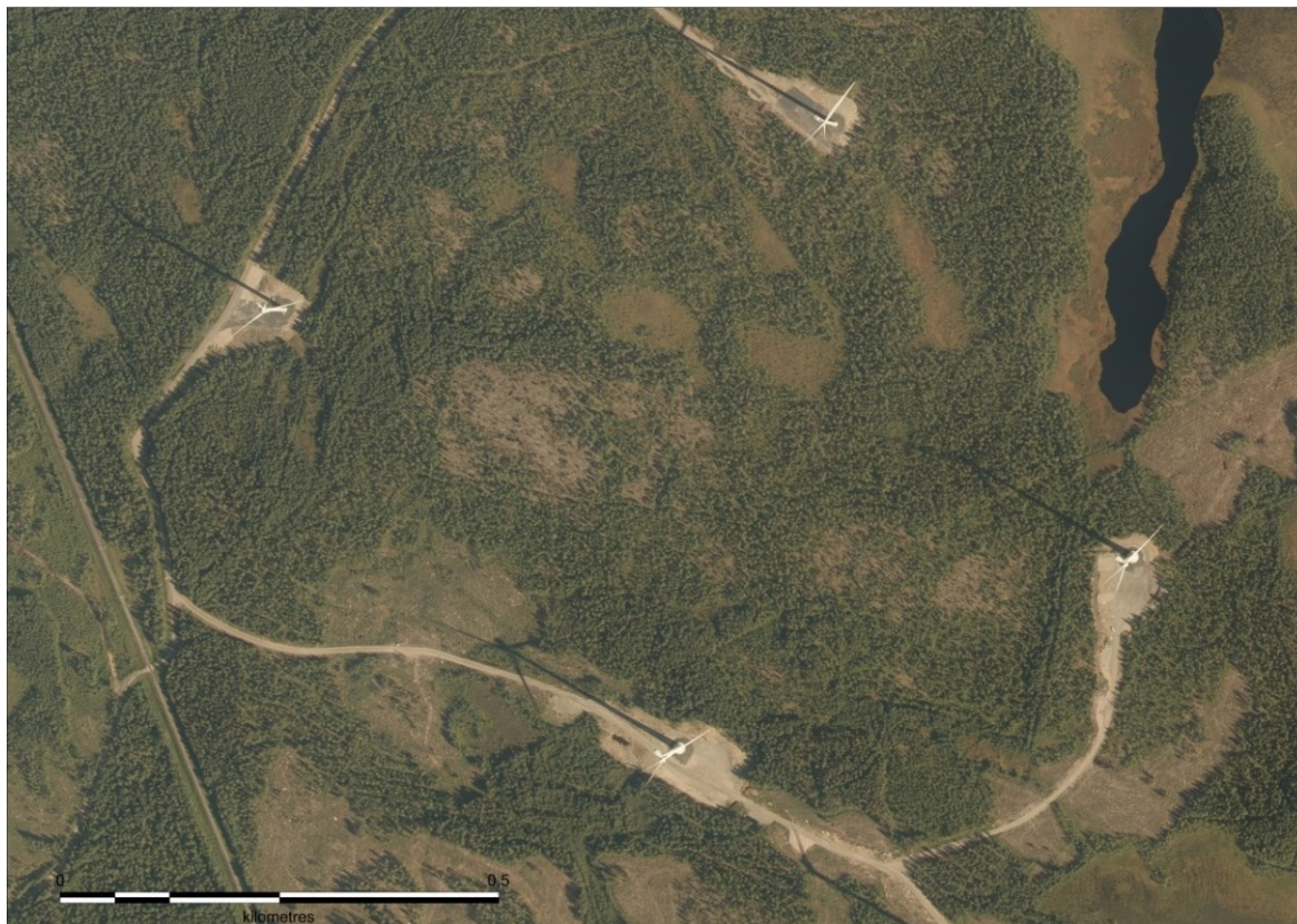
Kuva 5.1 Ilmakuva rakennetusta tuulivoimapuistosta (Maanmittauslaitos). Kuva ei ole Tuuramäen hankealueelta.
