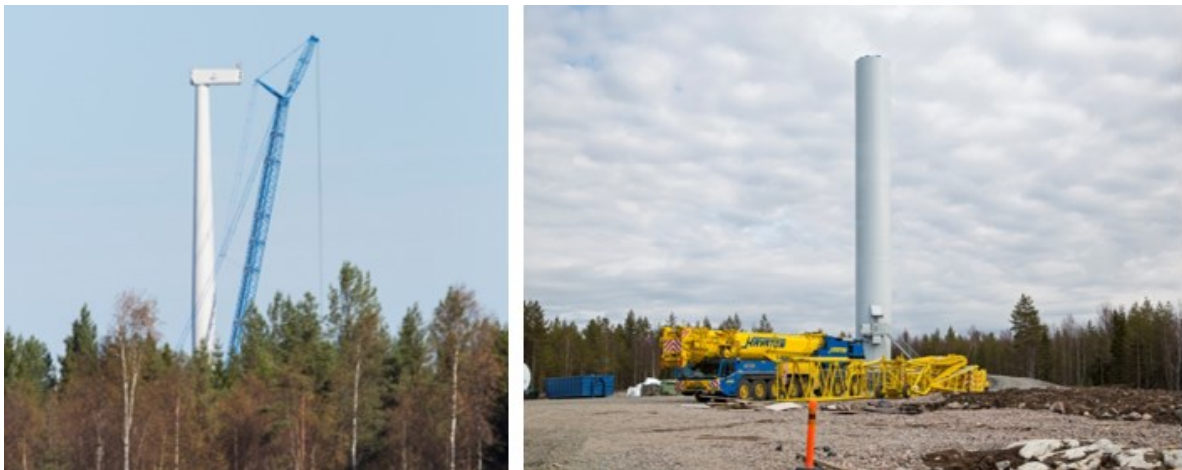
Kuva 5.14 Tuulivoimalan kokoamista (FCG Finnish Consulting Group Oy).
