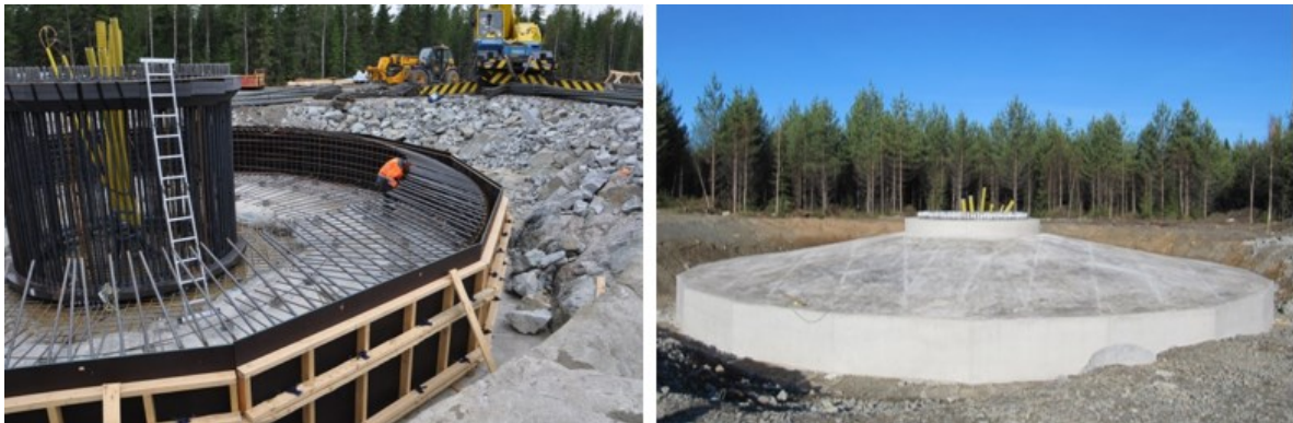
Kuva 5.13 Tuulivoimalan perustusten rakentamista (FCG Finnish Consulting Group Oy).
