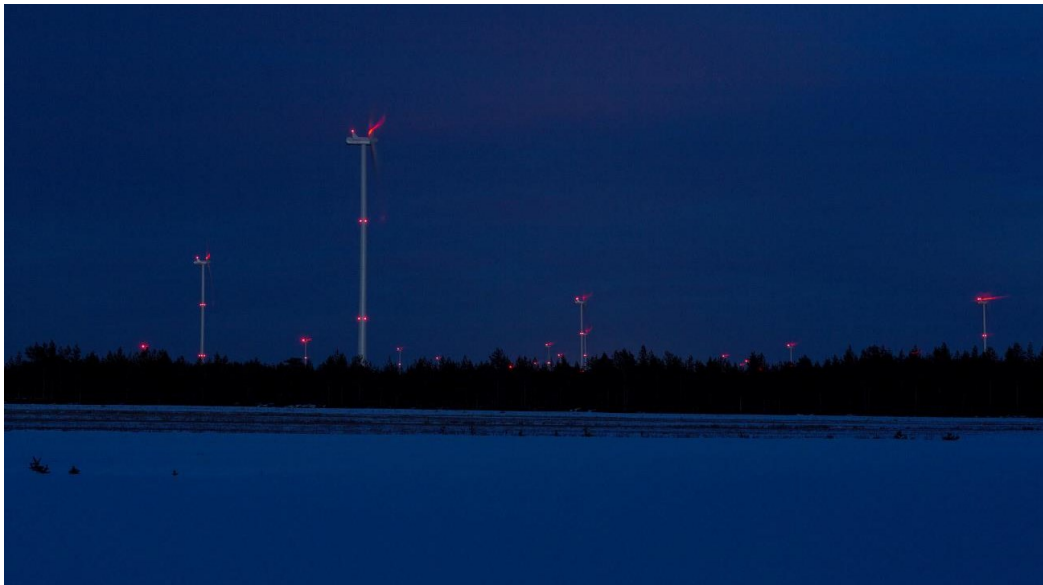
Kuva 5.5 Kiinteät punaiset lentoestevalot (FCG Finnish Consulting Group Oy).
