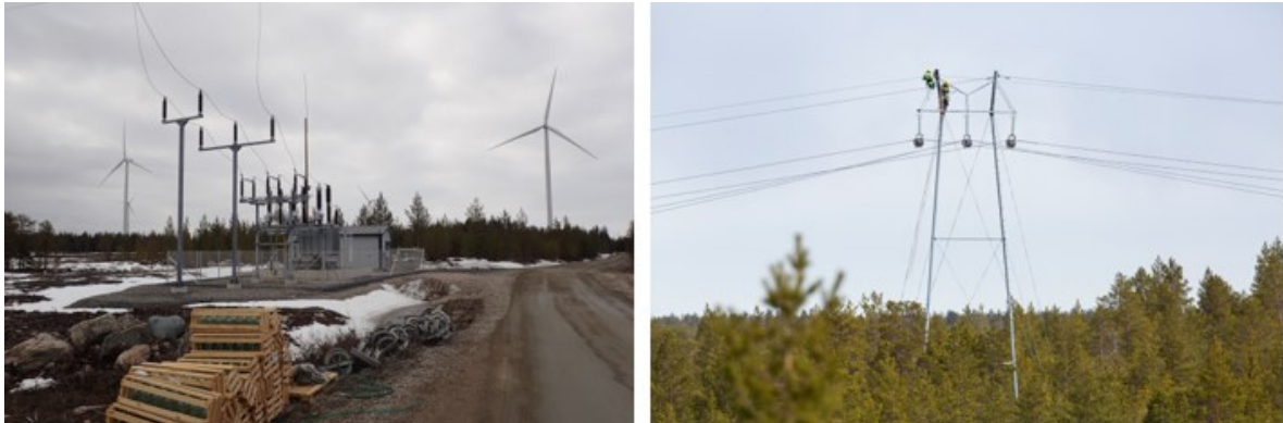
Kuva 5.16 Sähköaseman ja voimajohdon rakentamista (FCG Finnish Consulting Group Oy).
