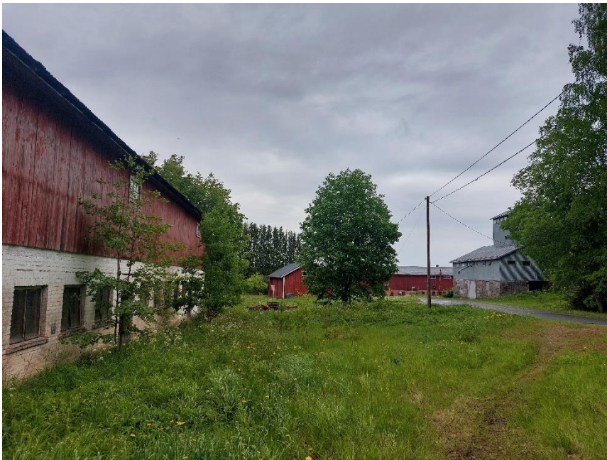
Kuva 84. Maitoisten tilan rakennuksia.
