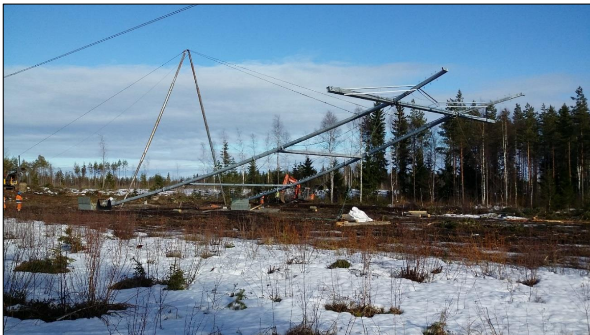
Kuva 10. Voimajohtopylvään pystytys.
