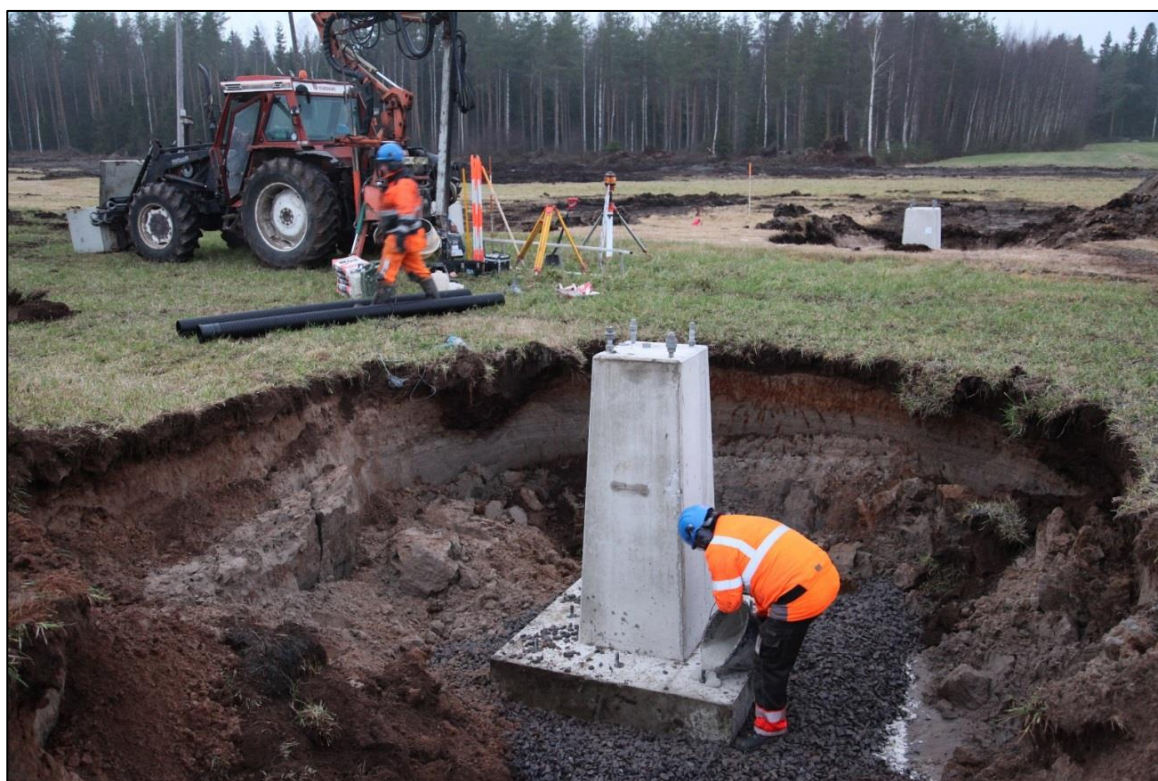
Kuva 8. Pylvään perustuselementin asentaminen.
