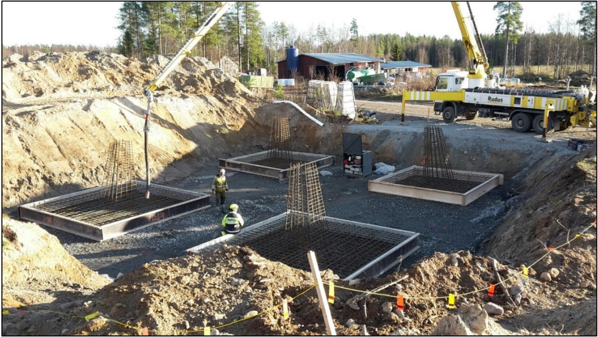
Kuva 9. Vapaasti seisovan pylvään perustuksen pohjatöitä.
