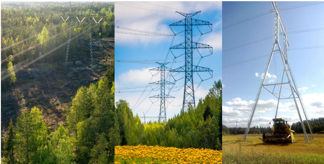
Kuva 39. Esimerkkikuvat eri pylvästyypeistä. Vasemmalla haruksin tuettu 400 kilovoltin portaalipylväs, keskellä vapaasti seisova kahden 400 kilovoltin voimajohtopylväs ja oikealla vapaasti seisova harukseton peltopylväs.
