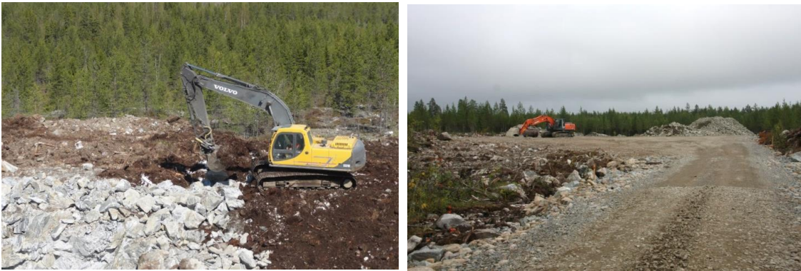
Kuvapari 3-11. Tuulivoimapuiston rakentaminen alkaa huoltoteiden ja pystytysalueiden rakentamisella (Kuvat: Ville Suorsa, FCG).
