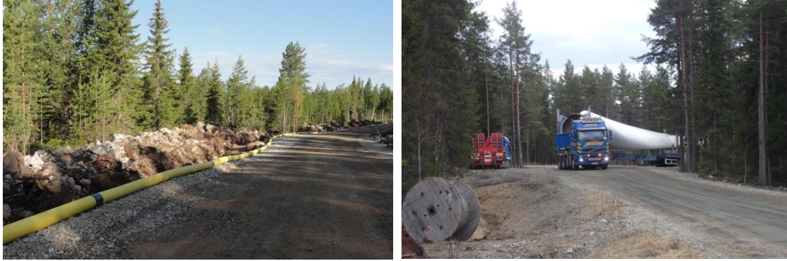
Kuvapari 3-9. (Vasemmalla) Esimerkki tuulivoimapuiston rakennus- ja huoltotiestä rakentamisaikana. (Oikealla) Tuulivoimalan osia kuljetetaan erikoiskuljetuksina. (Kuvat: Ville Suorsa, FCG).
