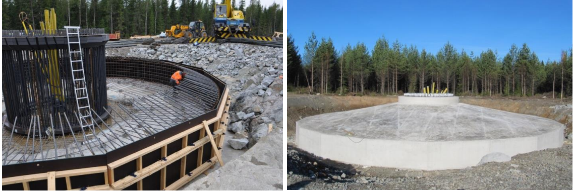
Kuvapari 3-13. Tuulivoimalan perustusten rakentamista. (Kuvat: Leila Väyrynen, FCG)
