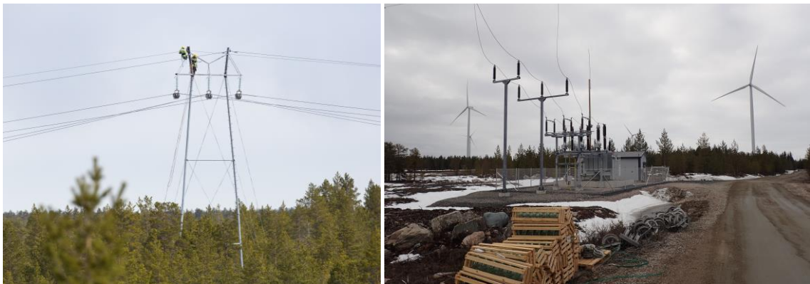
Kuvapari 3-15. Sähköaseman ja voimajohdon rakentamista. (Kuvat: Ville Suorsa, FCG)
