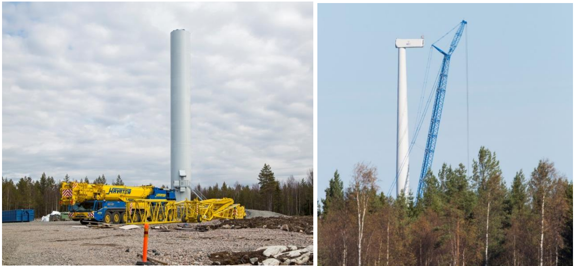
Kuvapari 3-14. Tuulivoimalan kokoamista. (Kuvat: Ville Suorsa, FCG)
