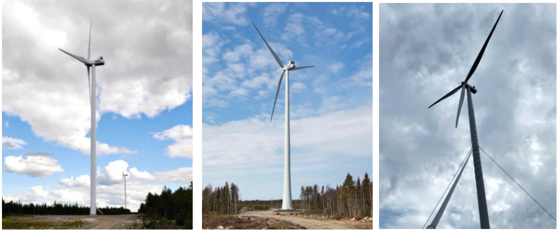
Kuva 3-6. Vasemmalla on esimerkki teräslieriötornista, keskellä hybriditornista ja oikealla harustetusta tornista. (Kuvat: Leila Väyrynen ja Ville Suorsa, FCG sekä Jarkko Finnilä, Carelin)
