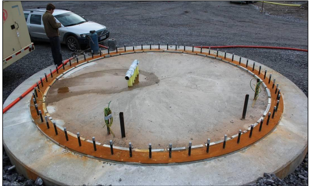
Figur 8. Exempel på vindkraftverks fundament i vilken diametern är cirka 6 meter.
