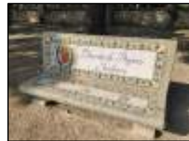
BANCOS GRANDES DE PIEDRA A REHABILITAR RECOLOCADOS
