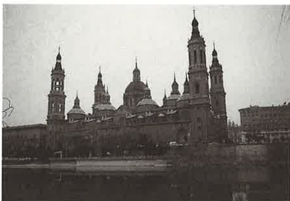
Vista del templo de Ntra. Sra. del Pilar Fachada Norte
