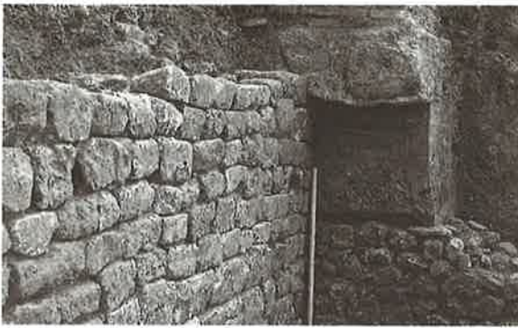
Detalle del aparejo de opus vittatum del muro oriental del mercado de época de Augusto
