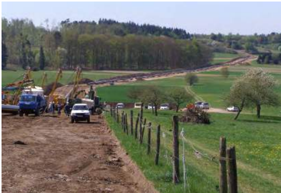
während des Leitungsbaus (Quelle: OGE)
