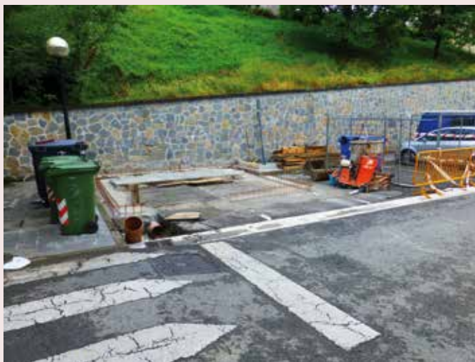
Biomasa galdara egin den orubea
