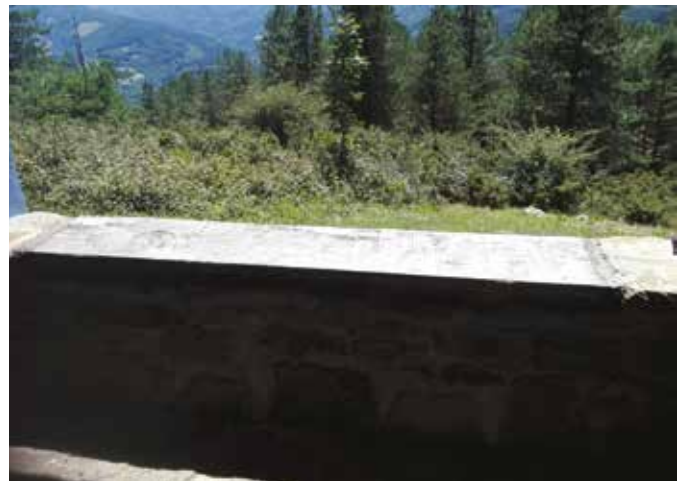
Elor Txikiko aterpetxeko pareta konponduta.
