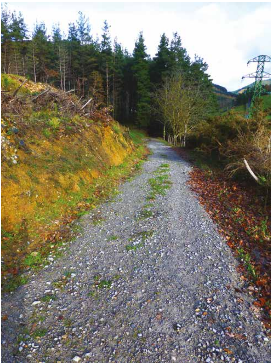
Beruntzetik Ordarguenera doan oinezkoen pistan erretenak garbitu eta "todo-uno" bota da.
