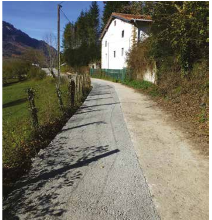
Arizti Zaharreko pista hormigonatu ondoren.
