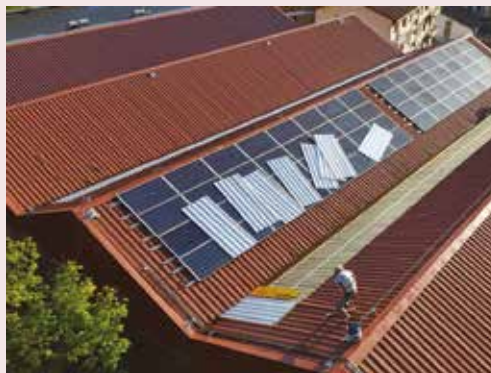
Teilatuko panelak aldatzen.
