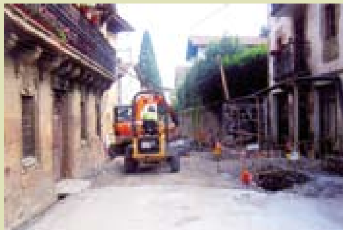
Juan Telleria kalea obretan
