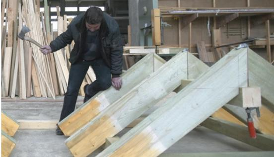
Die Sparrenhöhe wird nach statischen und ENEC-Erfordernissen festgelegt, beträgt bei wärmegeämmten Dachstuhl aber mindestens 220 mm ( $U = 0,19 \text{ W/m}^2\text{K}$ ). Die Schneelast ist mit  $2 \text{ kN/m}^2$  berücksichtigt. Alle von außen sichtbaren Teile, wie Sparren- und Pfettenköpfe, werden sauber gehobelt. Traufe und Ortgang werden mit einer Sichtschalung versehen und **mehrfach lasiert**.
