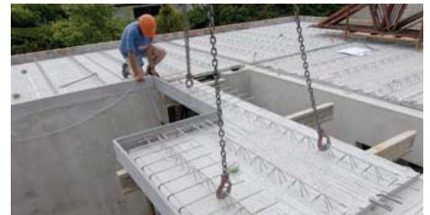
In Bereichen mit erhöhten Schallschutzanforderungen (z.B. an stark befahrenen Straßen oder Bahntrassen) werden Dachelemente (vergleiche Bild) als Sonderausstattung eingebaut. Hierdurch lässt sich das Schalldämmmaß gegenüber einem Zimmermannsdachstuhl wesentlich erhöhen. Diese Bauart erfüllt auch die Brandschutzanforderungen.
