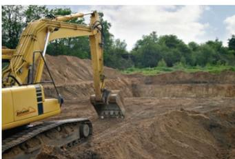
Im Bereich des geplanten Gebäudes wird der Mutterboden bis zu einer Stärke von max. 25 cm abgetragen und seitlich auf dem Grundstück gelagert. Boden der Bodenklasse 3 bis 5 gemäß VOB/C DIN 18300 (leicht, mittelschwer und schwer lösbarer Boden) heben wir aus und lagern das ausgehobene Material seitlich auf Ihrem Grundstück, mit Wiederverfüllung des Arbeitsraumes.
