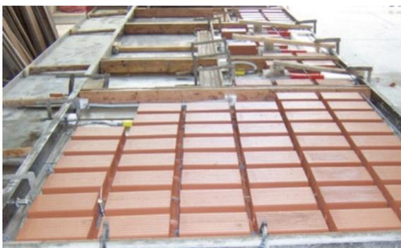
Die Außenwandkonstruktion ist einschließlich des Innenputzes und Außenputzes sowie des 175 mm starken Wärmedämmverbundsystems insgesamt 44 cm stark. Sie bietet aufgrund ihres bauphysikalisch vorteilhaften Aufbaues einen Wärmedämmwert, der die gesetzlichen Anforderungen weit übertrifft.
