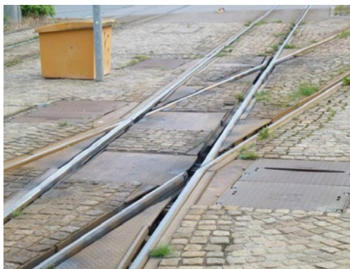
5. ÁBRA: Mozgó könyöksínes átszelés Zwackauba
