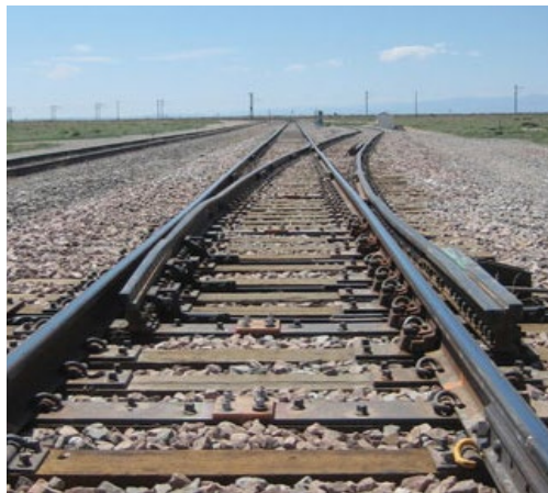
6. ÁBRA: Külső csúcssínes kitérő Észak-Amerikában
