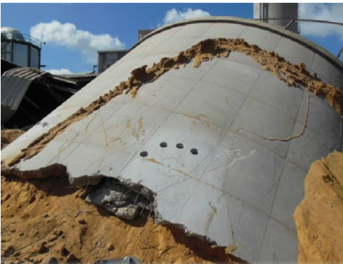
1. KÉP: Savkorrózió okozta sérülések miatt összeomlott siló
