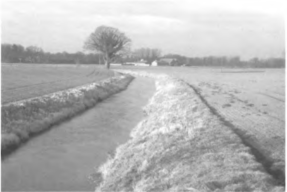
Abb. 1: Stark begradigter und ausgebauter Bachlauf am Eltingmühlenbach.
