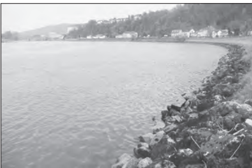
Abb. 20: Der Blockwurf am Donauufer an der oberen Donaulände beherbergt ca. 30 Flechtenarten, die auf Grund der besonderen mikroökologischen Bedingungen hier ihren einzigen Standort in Linz haben.
