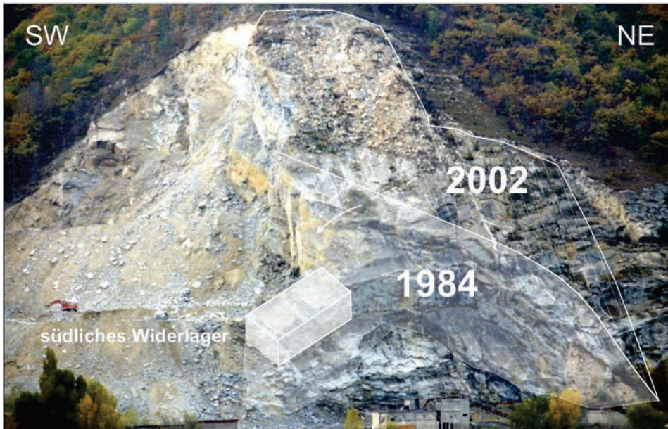
Abbildung 4: Felssturz am 4.10.1984 und beim Ereignis 2002 abgeglittene Felsmassen.
