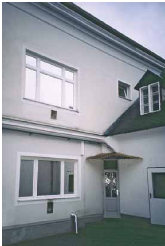
Abb. 13: Rückseite des sog. Herrenhauses (Oed Nr. 1) im Fabriksgelände der Familie v. Rosthorn in Waldegg-Oed: Trotz verschiedenster Umbauten ist der separate Eingang zur ehemaligen Wohnung (links) von Mathilde & Rudolf Kner in den Jahren 1849-1856 erhalten (vgl. p. 29) (11.8.2007).
