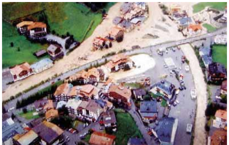
Abb. 27: Sorgloses Bauen im Überschwemmungsbereich von zwei Wildbächen (Bild: Archiv des Verfassers).
