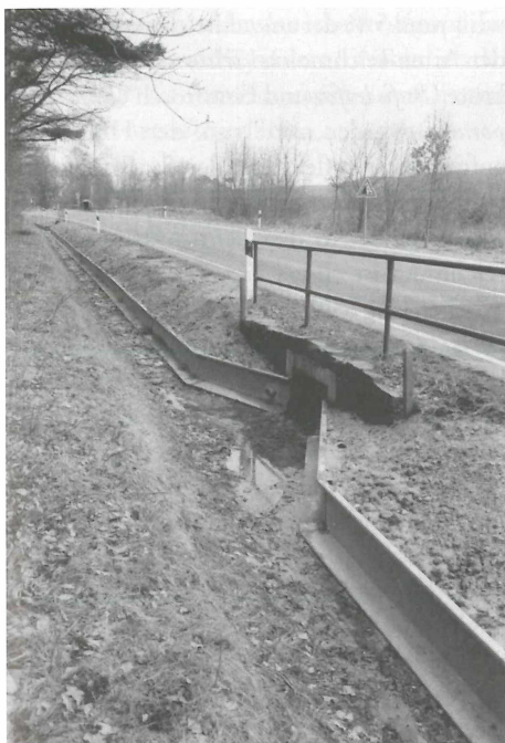
Abb. 2: Leiteinrichtung und Eingangsbereich eines Durchlasses auf der Ostseite der Straße.
