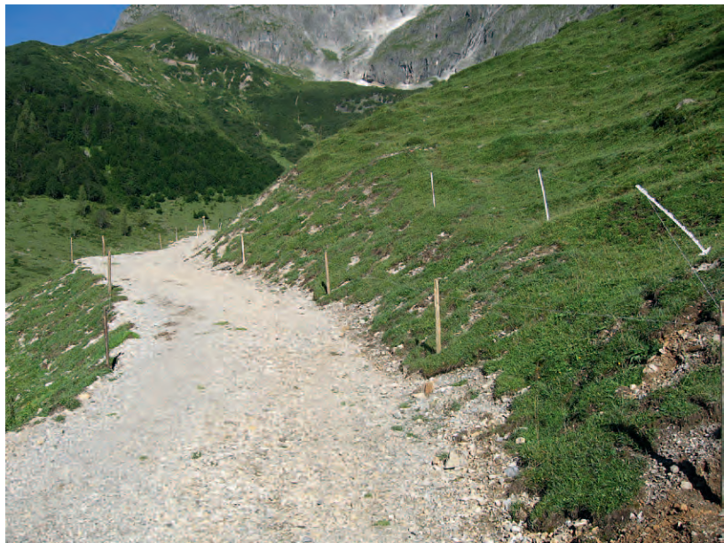
Vorausschauende Planung beim Wegebau schließt auch die Auszäunung frisch rekultivierter Böschungen gegen Viehvertritt ein, um den Erfolg der Begrünung langfristig zu sichern (Bild: H. Hinterstoisser).
