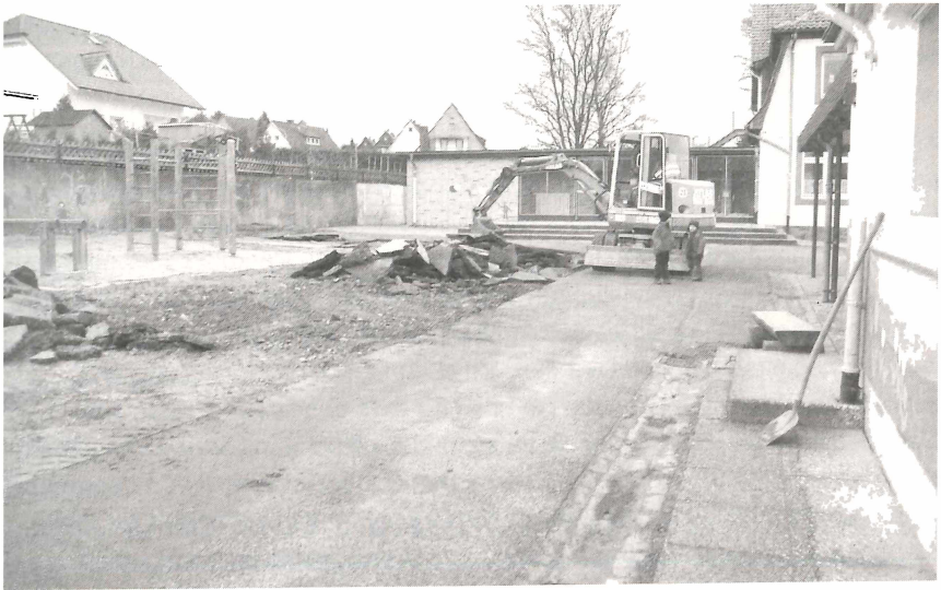
Foto: Schulhof Grundschule Salzderhelden vor dem Umbau
