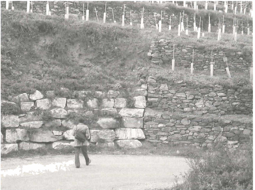
Abb. 4: Unterschiedliche Ausführung von Stützmauern in den Spitzer Weingärten
