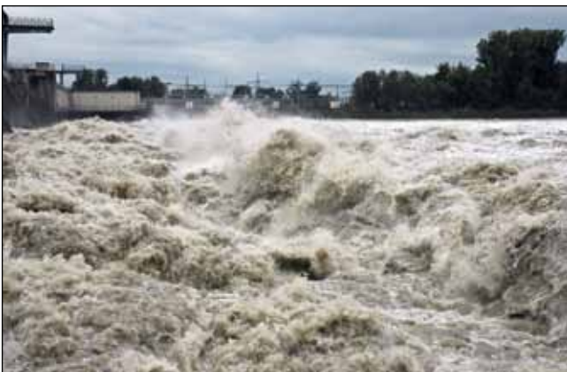
Abb. 1: Wassermassen von bis zu mehr als 5.000 Kubikmetern pro Sekunde donnern über die Schleusentore der Innkraftwerke – hier in Obernberg am Inn.
