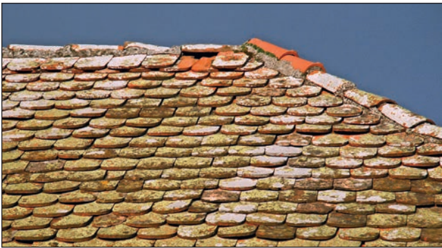
Abb. 56: Altes Dach im Sauwald, bewachsen mit fast 50 Arten, 2019 durch ein hochglänzendes Blechdach ersetzt (Haibach b. Passau). Foto: Franz Berger
