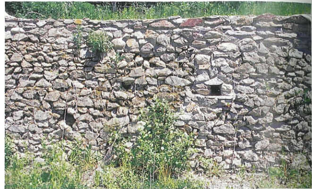
Abb. 4: Aufnahme 16, rechts Mitte das Balkenloch (Fledermauskot). Aufn. Arge NATURSCHUTZ
