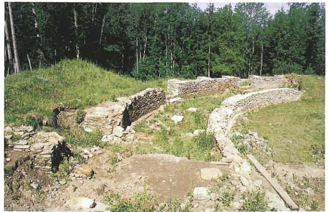
Abb. 8: Blick auf Bereich Südtor, Zugänge 1 und 2. Aufn. Arge NATURSCHUTZ
