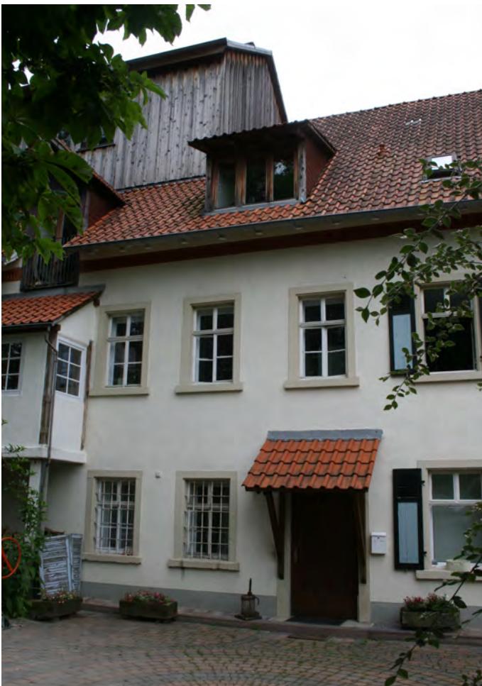
Abb. 4: Untere Mühle in Baiertal, heutiger Zustand (phot. G. Gottschlich 2015)
