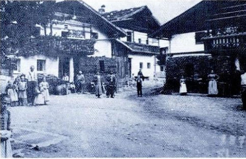
Abb. 1: Geburtshaus Johann Kellerers in Stans (in Bildmitte etwas zurückversetzt, beim „Lattn“, 1872, Archiv F. Lägner und in Heimatbuch der Dorfgemeinde Stans 1992)
