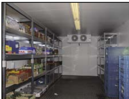
Interiér nového chladičho boxu Interior of the new ice box
