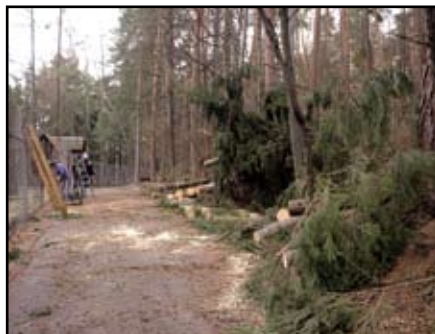
Opravy plotů poničených vichřicí Emma (3. 3.) Repairs of fences damaged by the storm "Emma" (Mar. 3)
