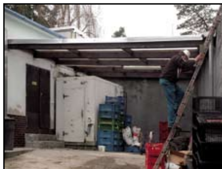
Zastřešení vstupního prostoru a chladičích boxů u pavilonu šelem Roofing over the entrance area and ice box near the Big Cat Pavilion
