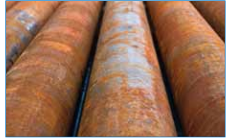
Korrosion verursacht unnötige Kosten.
